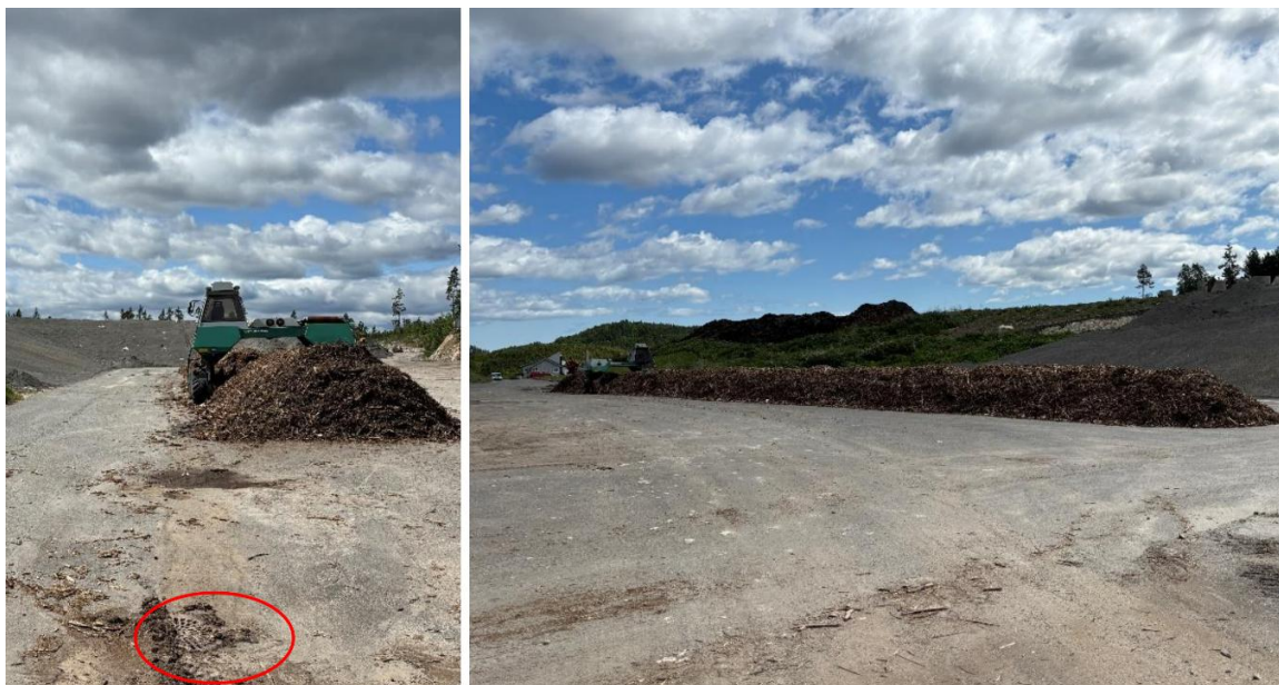
Figur 3 Kompostering av slam på asfaltert areal. Dette gjøres ikke lenger. Området skal heretter brukes til kompostering av hageavfall. Hageavfallet skal legges i ranker og vendes ved bruk av rankevender. En sandfangskum er markert med rød ring
