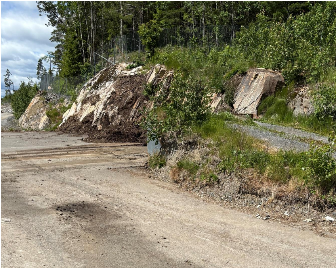
Figur 10: Rampe for lossing av slam ned på den asfalterte flaten, der ev. vann ledes til sandfangkum og spillvannsledningen.
