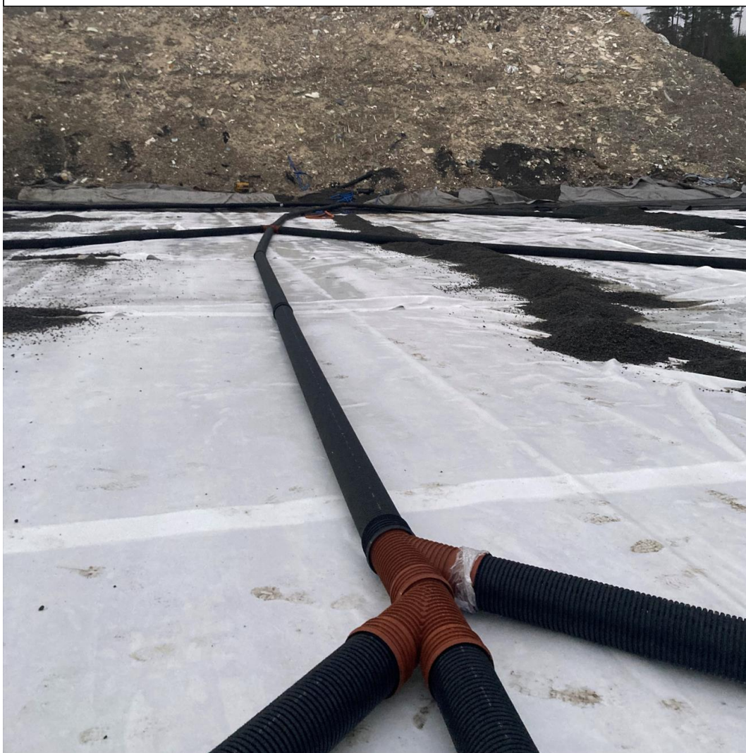
Bildet viser dreneringsløsning. Ble koblet til allerede klargjort drenering fra forrige etappe.
