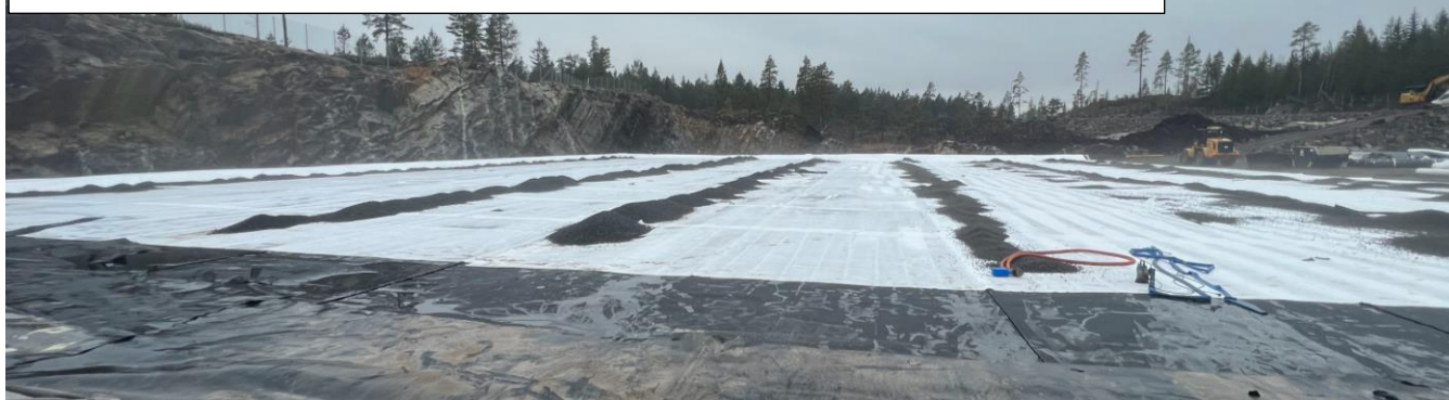
Membran, plastmembran og fiberduk lagt ut. Klargjøring for dreneringsrør og drenslag.
