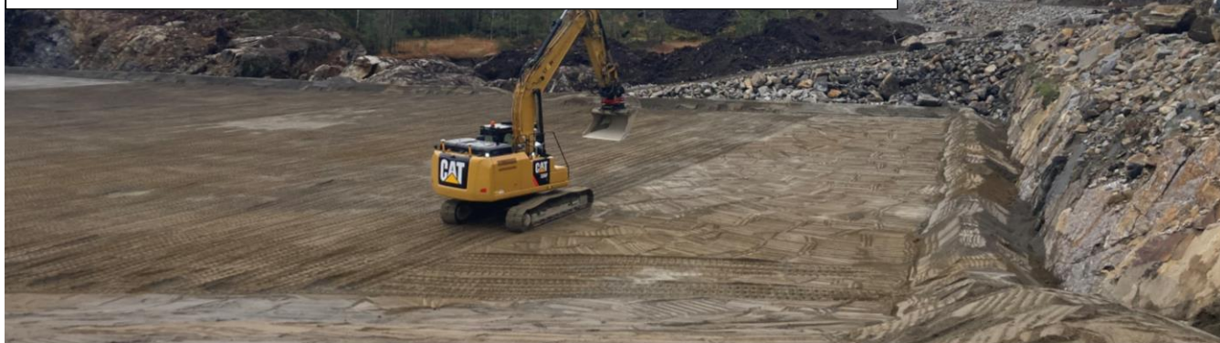
Membran, plastmembran og fiberduk lagt ut. Klargjøring for dreneringsrør og drenslag.
