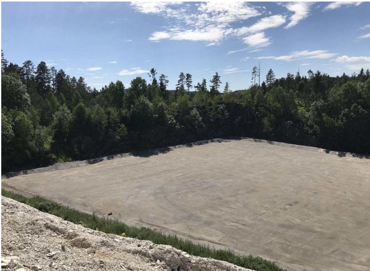
Figur 5. Oppbygging av bunn før legging av bentonittmembran og membran av HDPE etc, jf. Figur 13. Vi ser av bildet at det er lagt om en mindre voll rundt deponiet. Dette gjør at bunntettingen fungerer som et basseng der sigevann ledes bort via sigevannsledningene som etableres over bunntettingen.
