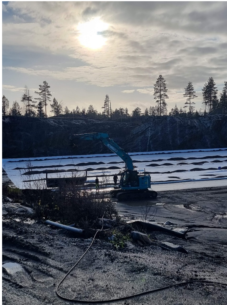
Figur 1: Legging av membran på deponiets etappe 2a.
