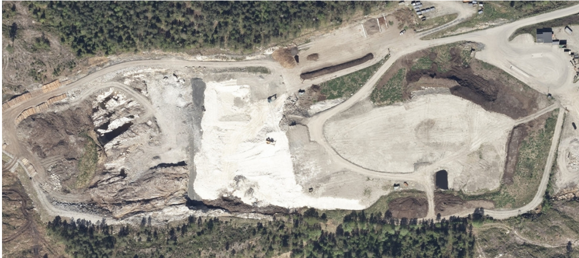
Figur 3: Bildet kan gi innblikk i at det ikke er fylt avfall mot fjell og et det er anlagt en anleggsvei rundt deponiet.
