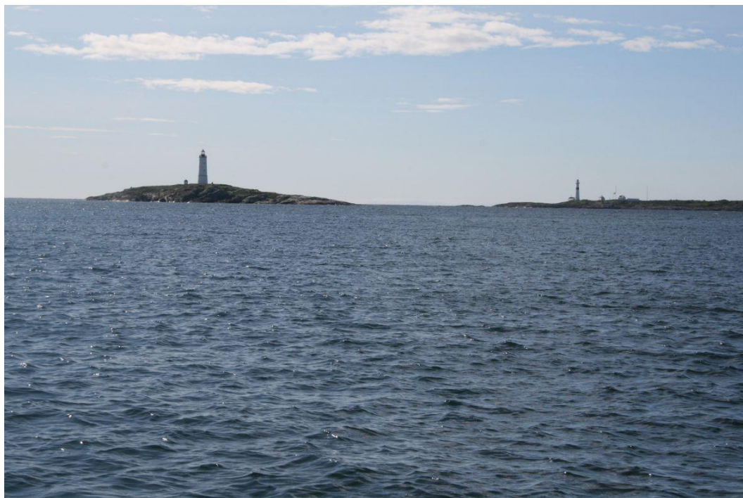
Figur 2.23 Store og Lille Torungen fyrstasjoner. Fra 1844. Begge er fredet. Innseilingen til Arendal går mellom disse og inn Galtesund. Foto Molaug, NIKU.
