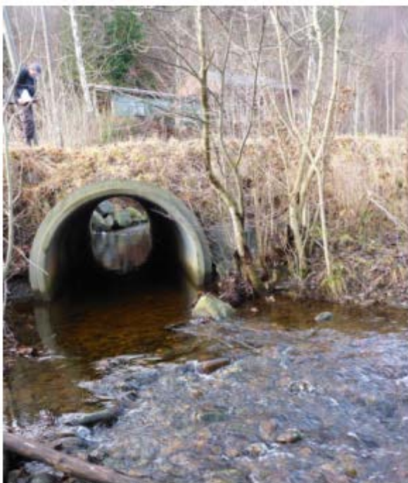
Figur 39. Songebekken har mange kulverter, noen er gode (v) andre er vandringsbarrierer (h)
