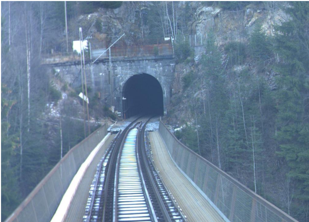
Tunnel i Nybuåsen. Foto: Jernbanelverket
