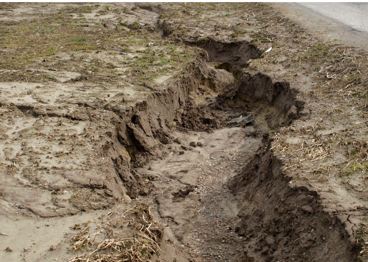
Erosjon som følge av kraftig nedbør. Foto: Aud Torild Stensrød
