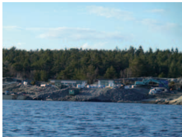
Grunnarbeid er i full gang på en erstatningshytte i Kragerøskjærgården.
