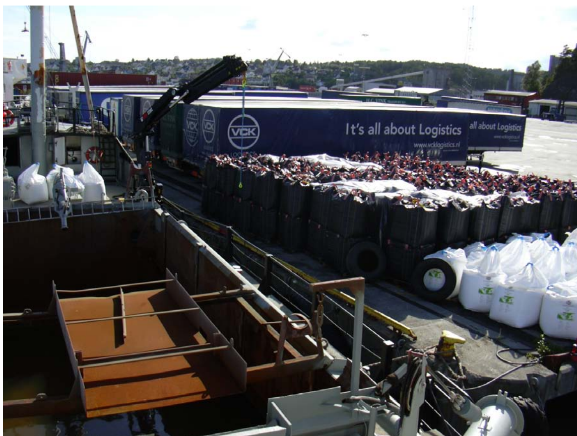
Sekker med kull og salt på kaia i Brevik, klare for innblanding med mudret leire.
