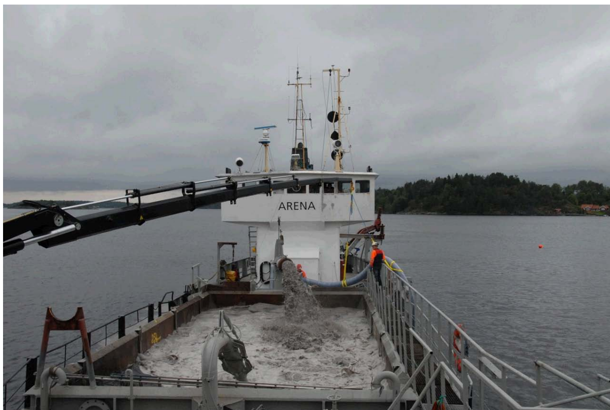
Kalksteinholdes i suspensjon i lasterommet på Arena før utlegging.
