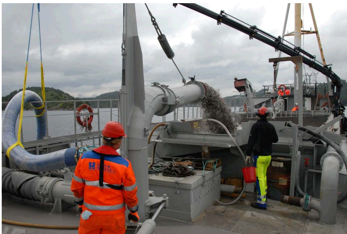
Suspender kalkstein pumpes ut via nedføringssrøret til venstre i bildet, mens massene fortsatt sirkuleres i lasterommet.
