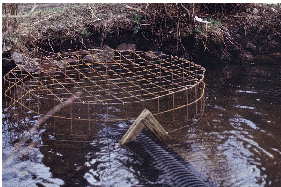
Figur 13.5 Rørmontering. Foto: S. Lisle
