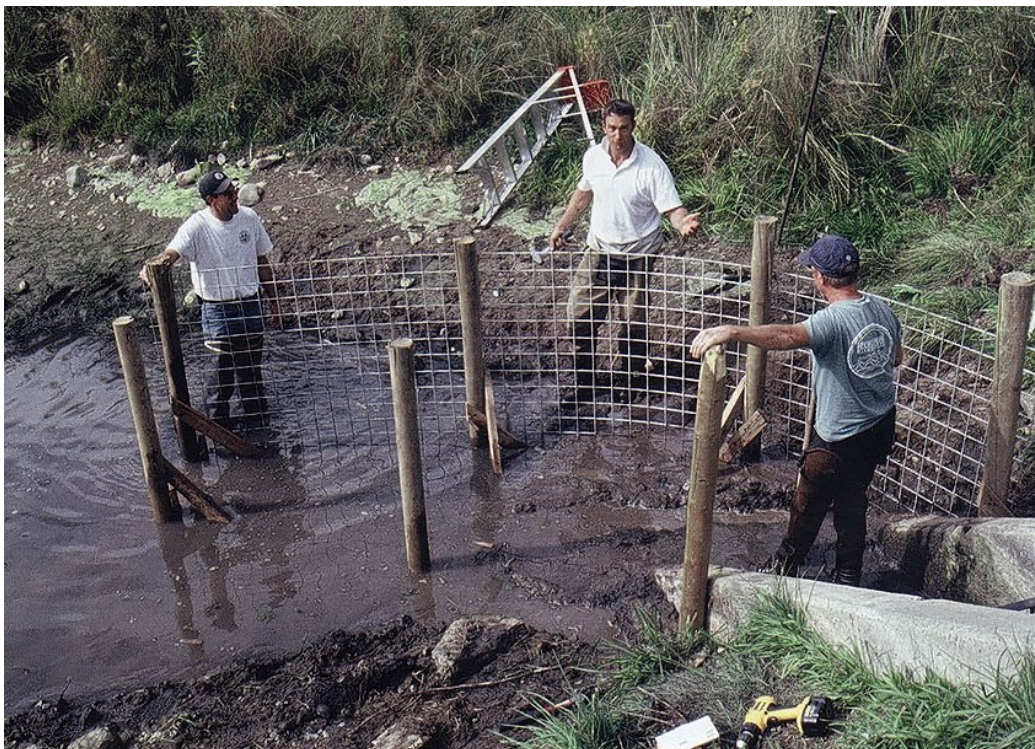
Figur 13.7 Bygging av kombinert for-dam og nettingsylinderfilter. A) For-dam bygges
