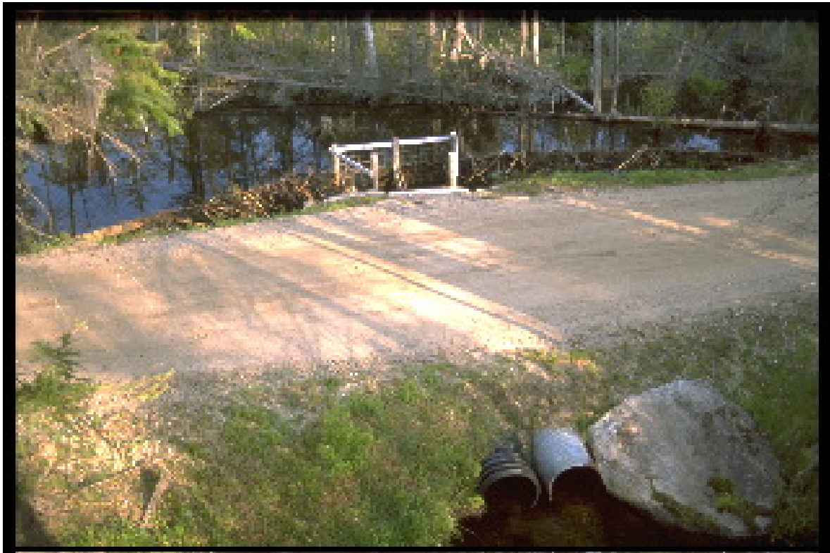
Figur 11.1 Enkel for-dam med beverdemning bygget utenpå.
