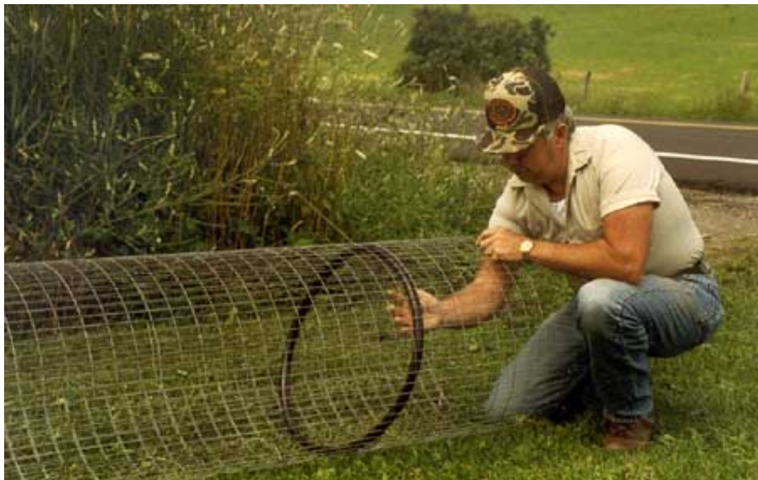
Figur 10.2 Montering av stålring som tilleggsstøtte. Foto: BWW
