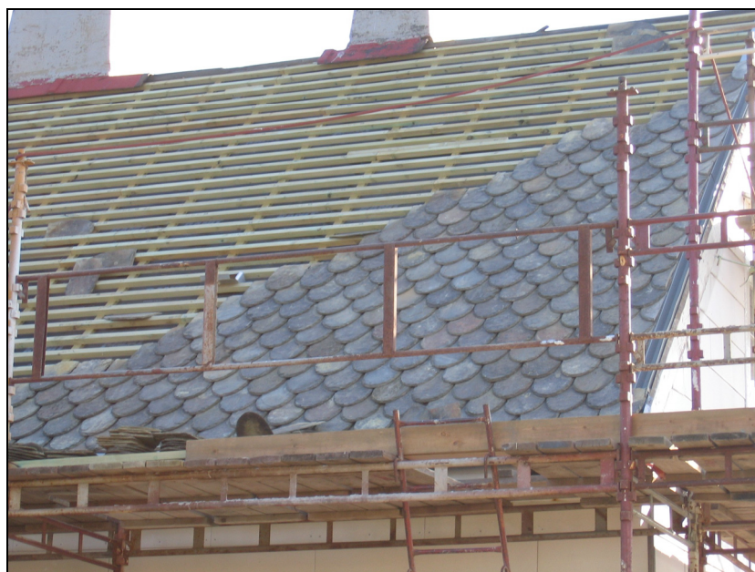
Nytt skifertak legges på fyrmesterboligen på Langøytangen Fyr. Foto: Leif Karlsen
