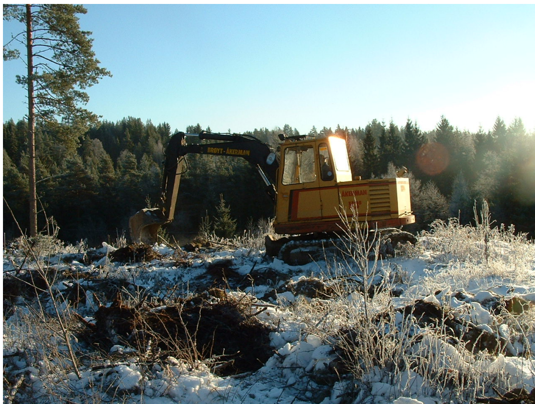
Markberedning med gravemaskin. Markberedning ble utført på 1330 daa i 2017.
