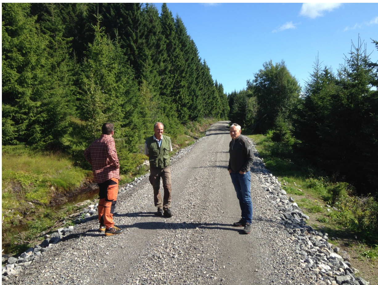
Skogsbilveg ombyggt med bære- og slitelag av knust fjell. Økterhøydaveien, Skien kommune. Foto: Per Kristoffersen
