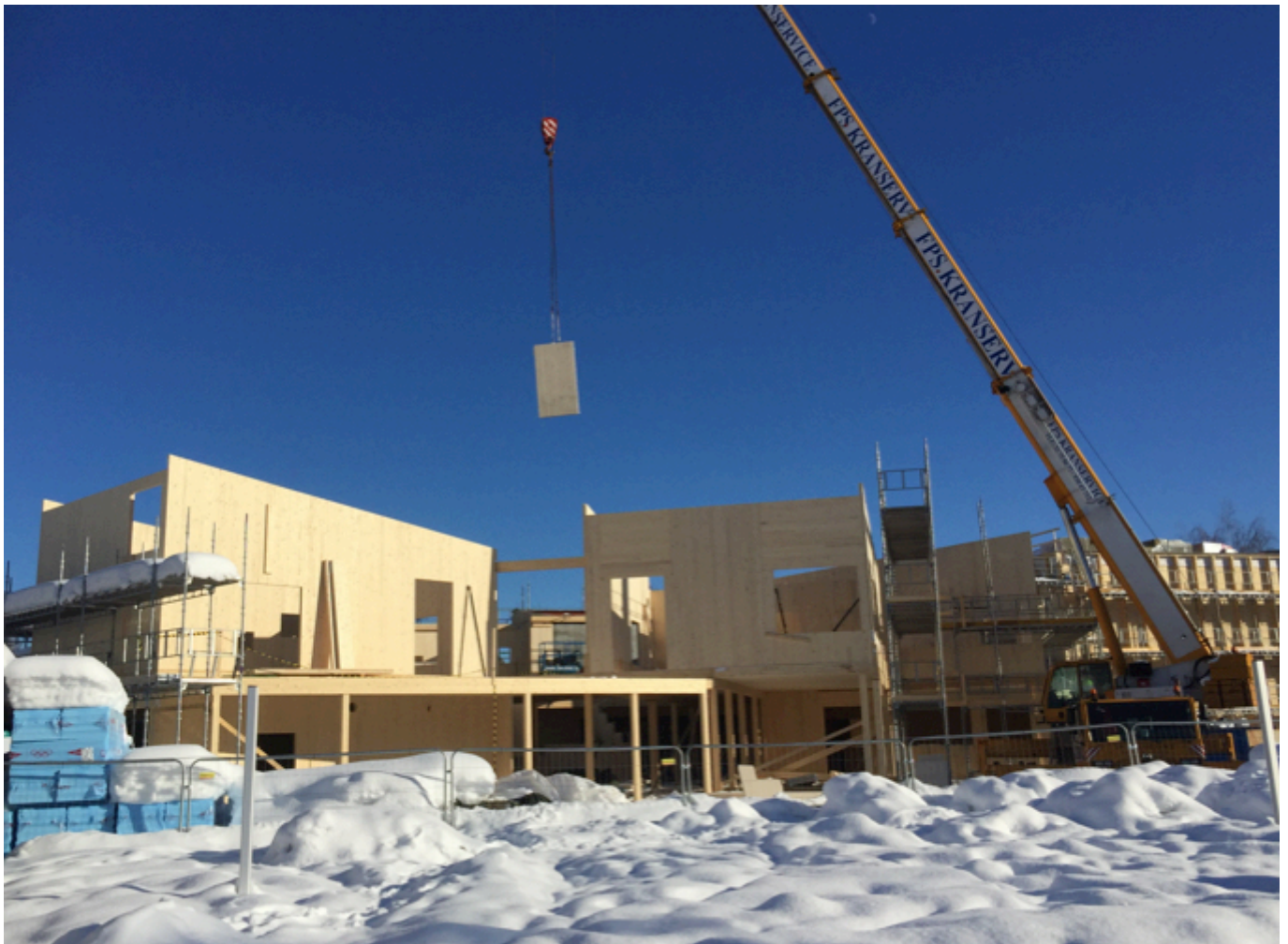
Sauland skule er den første skolen i Telemark som oppføres i massivtre.
