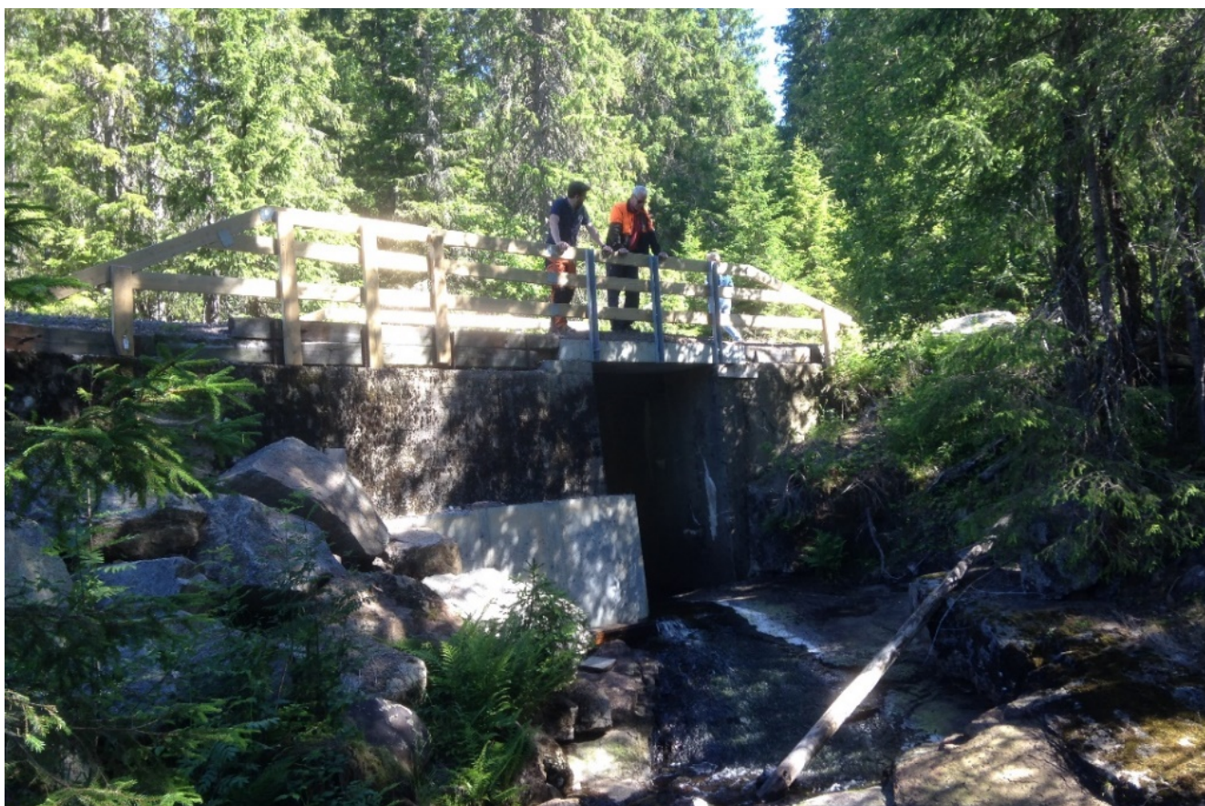
Ombygd bru med brudekke av prefabrikkerte betongelementer, rekkverk og restaurerte brukar, Romsdalsveien, Grorud i Siljan kommune. Foto: Per Kristoffersen
