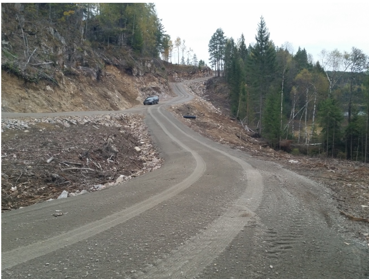
Hestnesvegen med ferdig grusa topplag
