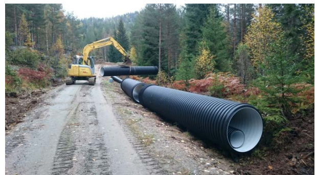
Legging av nye stikkrenner i Drangedal
