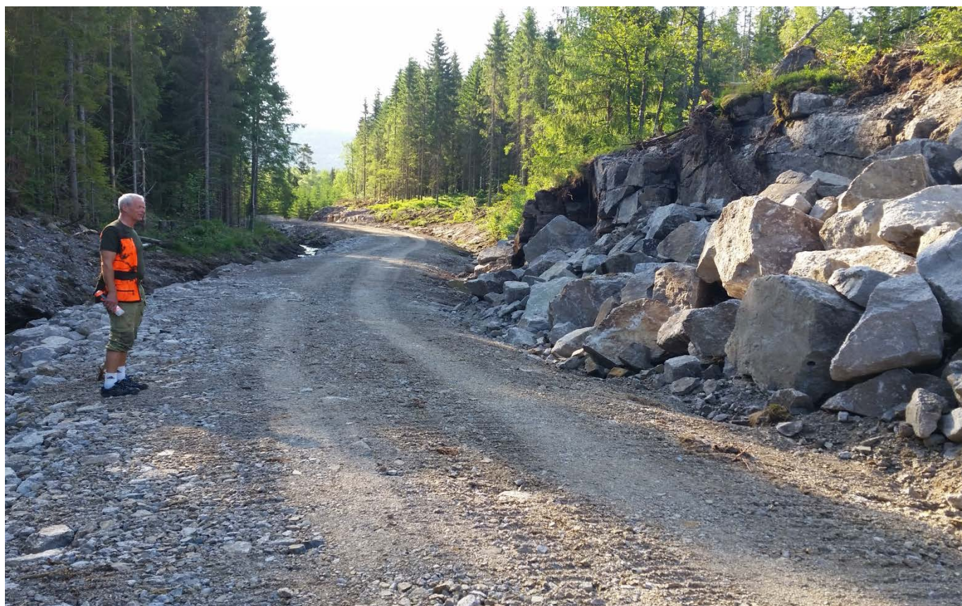
Ombygging av skogsbilvei, Movannsveien, Fritzøe skoger, Siljan
