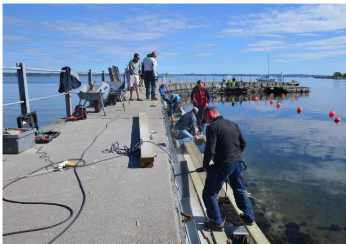
Årlig vedlikehold av kulturminnet moloen(1892) Gammelt tredekke fra 1976 ble skiftet ut og rekkverket pusset og malt.
