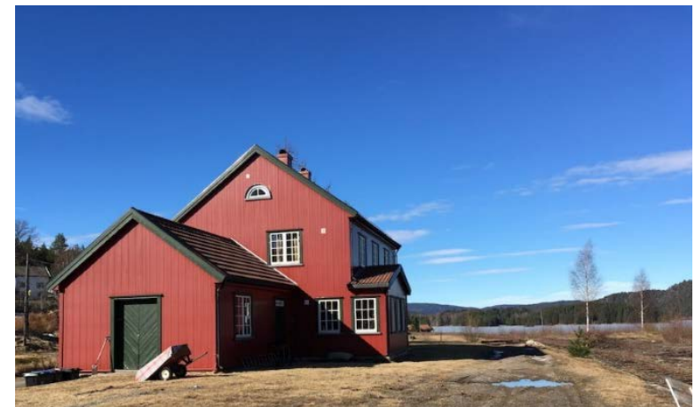
Figur 2-2 Merkebekk stasjon med stasjonsbygningen som i dag nyttes som bolig. Kilde: Skinnelangs.no Foto: Erlend Garåsen
