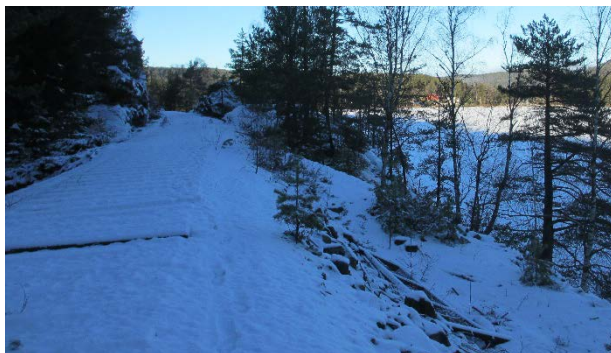
Figur 4-4 Skråning med vegetasjonsdekke som gir tilstrekkelig sikring.
