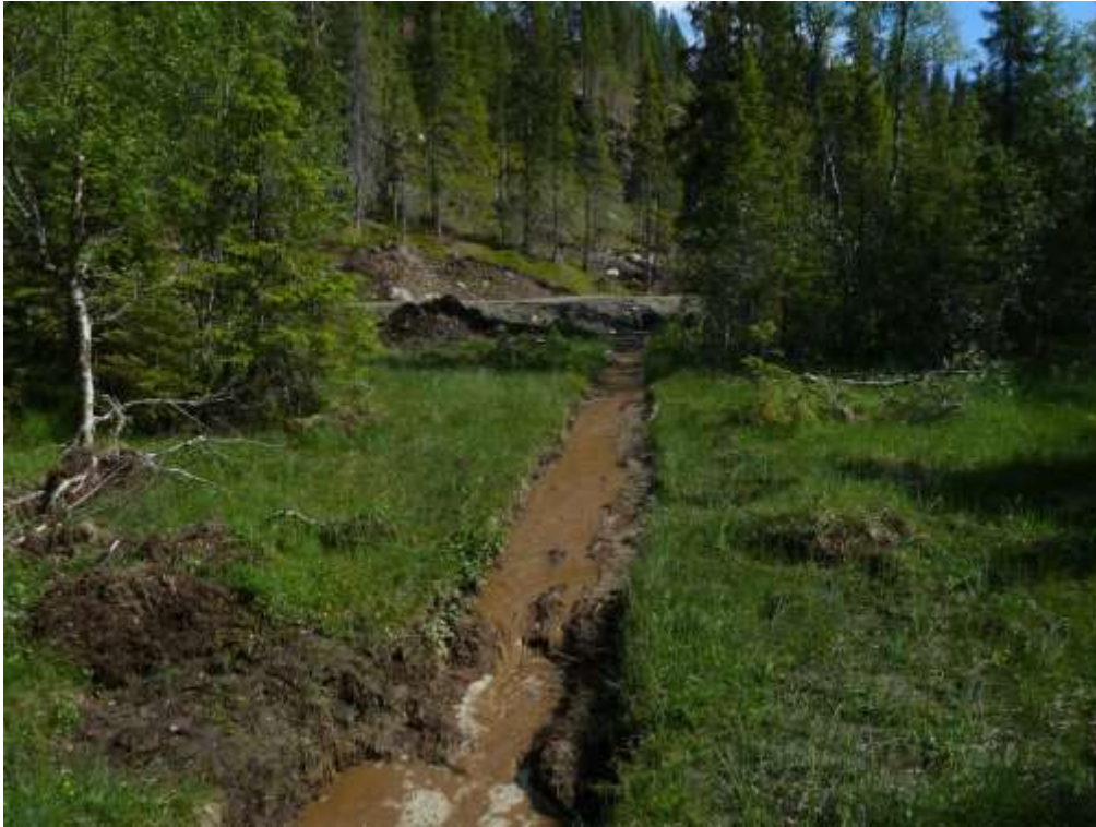
Figur 11 Nygravd grøft gjennom rikmyr ved Spannskletten, med en ny skogsbilveg som har skåret gjennom den verdifulle kanten til rikmyra. Selv om Skaun er en presskommune for utbygging som følge av nærheten til Trondheim by, er det tradisjonell landbruksdrift som utgjør den største trusselen mot naturmangfoldet på landjorda i denne kommunen. Manglende kunnskap og hensyn til naturverdiene i skog er en sentral årsak til dette. Foto: Geir Gaarder
