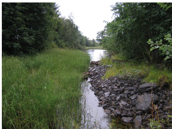
Viksåsen NØ, dam 2. Eldre fyllinger av grov stein på vestsiden av dammen.
