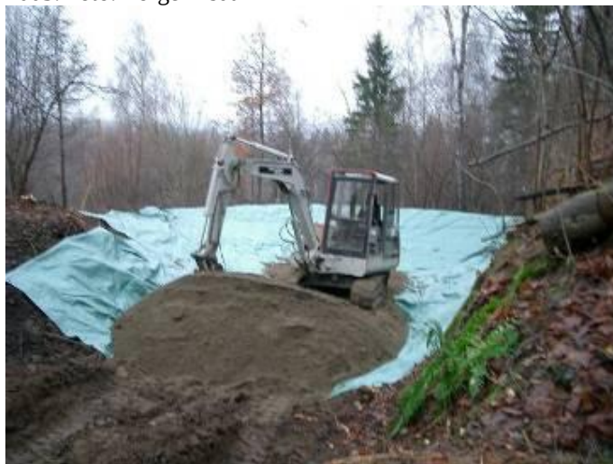
Figur 2 ”Vollentoppen salamanderdam” under anleggelse høst 2003. Foto: Torgeir Isdahl
