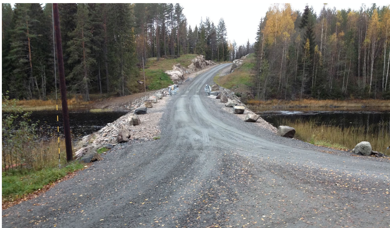
Sundbrua – Aurskog-Høland. Foto: Stian Sandbekkbråten
