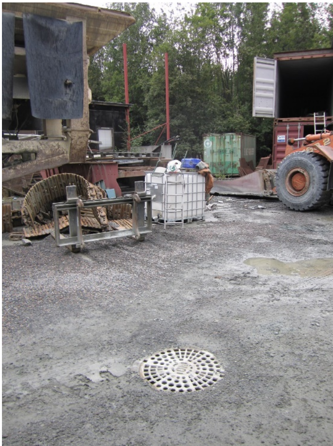
Åpent sluk på området i nærheten av verkstedet.
