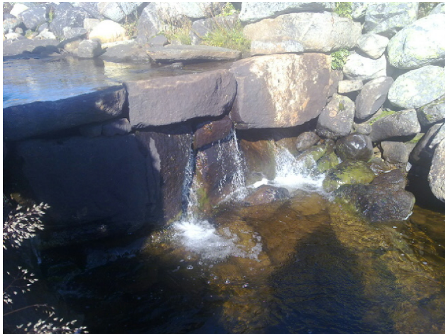
Bilde av eksisterende fiskesperre ved Stigstuv
