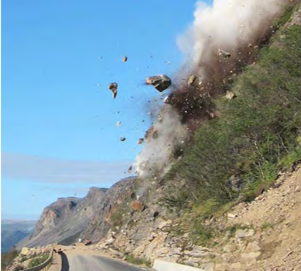
Figur 7: Eksempel på steinsprang mot veg i forbindelse med rensk av fjellside. Bildet gir en god illustrasjon på at blokkene spretter høyt og ikke bare følger bakken (fra Betongrenovering Drift AS informasjonsvideo 2009).
