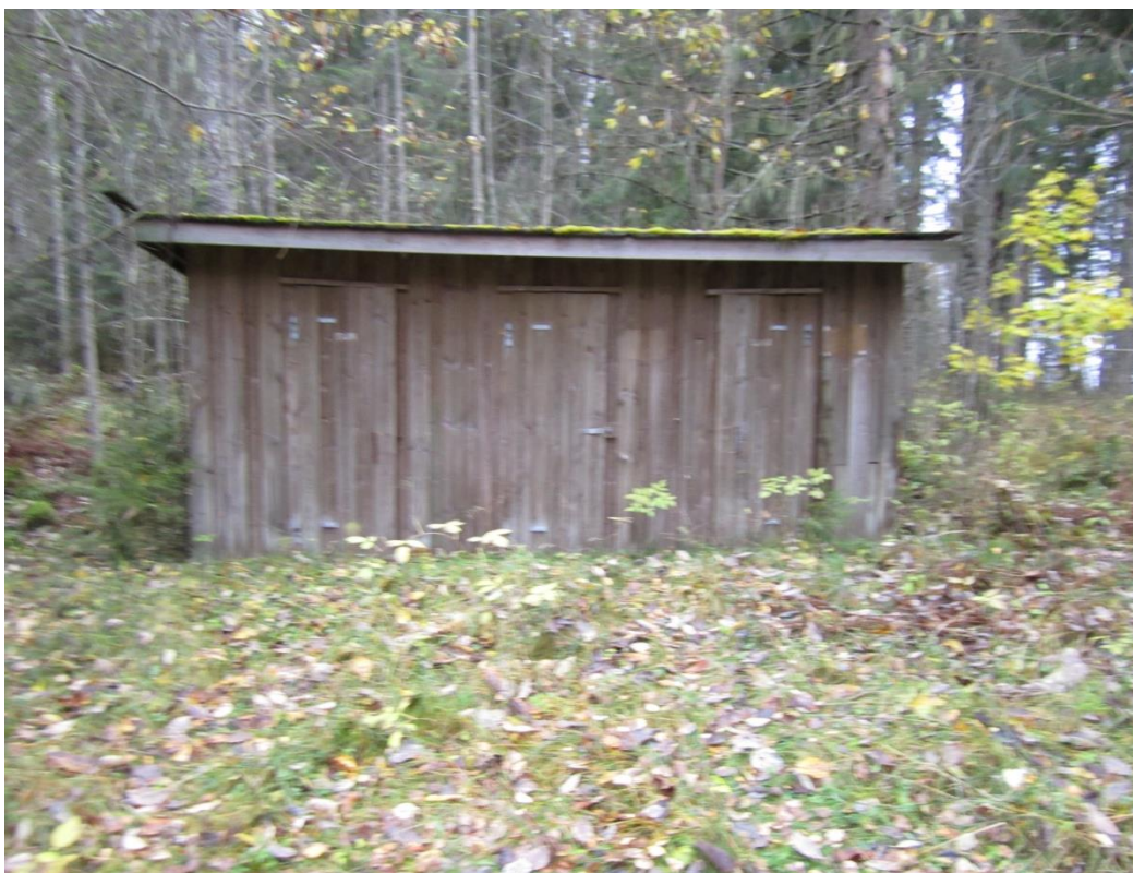
Sanitæranlegget på Skagnesodden
