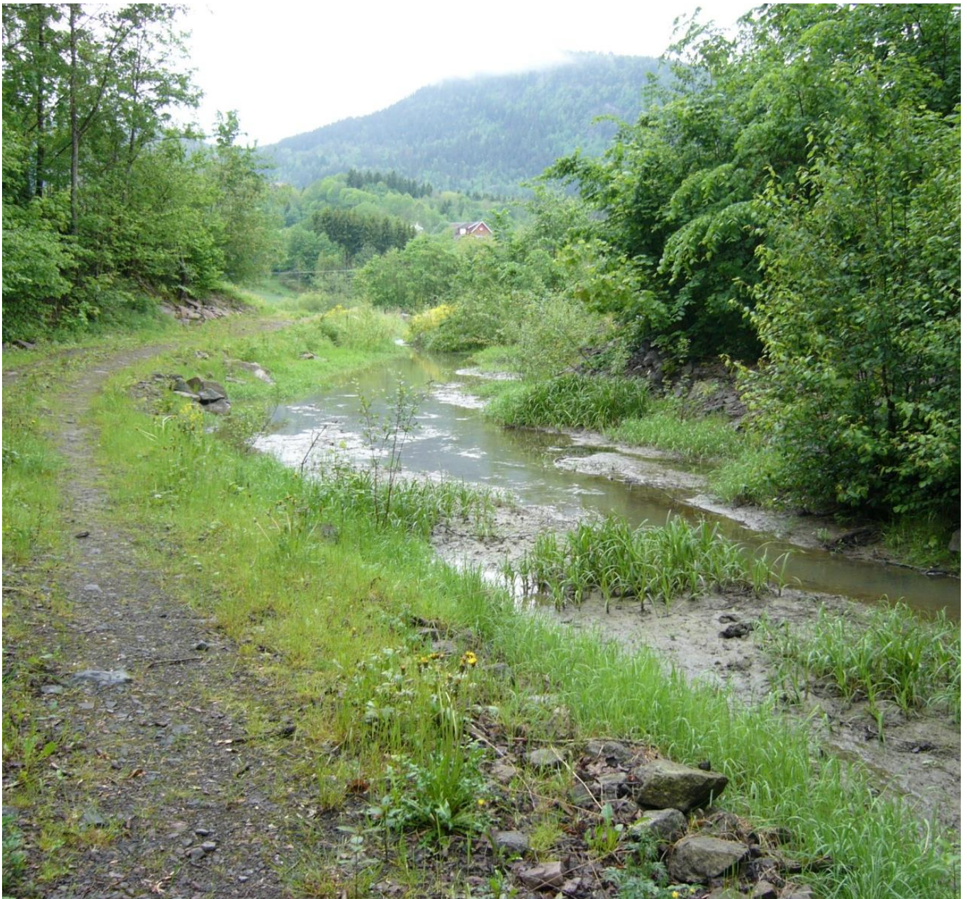
Foto 14: Fangdam med behov for sedimenttømming. Utløpet av ravinebekk - Nordalbekken i Lier
