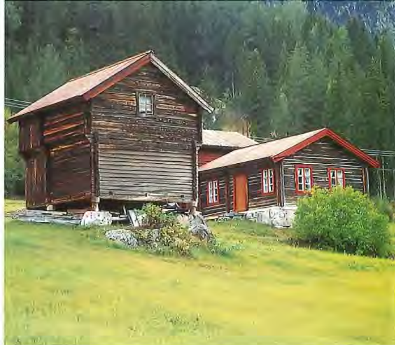
Tradisjonell byggeskikk fra 1800-tallet på Hallibakken. Foto: Jørn Jensen.
