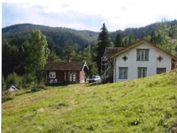
Våningshuset på Juveli mellom er under restaurering. Tunet er fortsatt åpent, mens innmarka rundt er i gjengroing.
