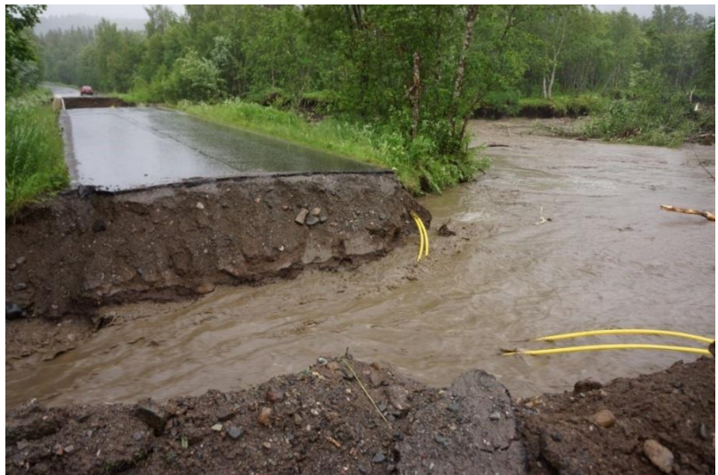
Veibrudd i Målselv i 2012 hvor kabler ble revet av. Foto Ole Asheim
