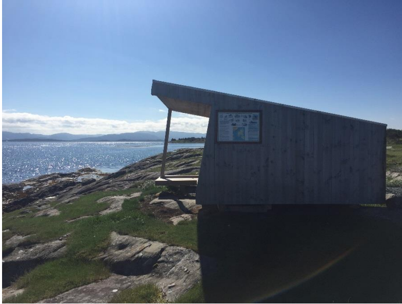
Bilde 8: Gapahuk ved brua over Kråkvågsvaet
