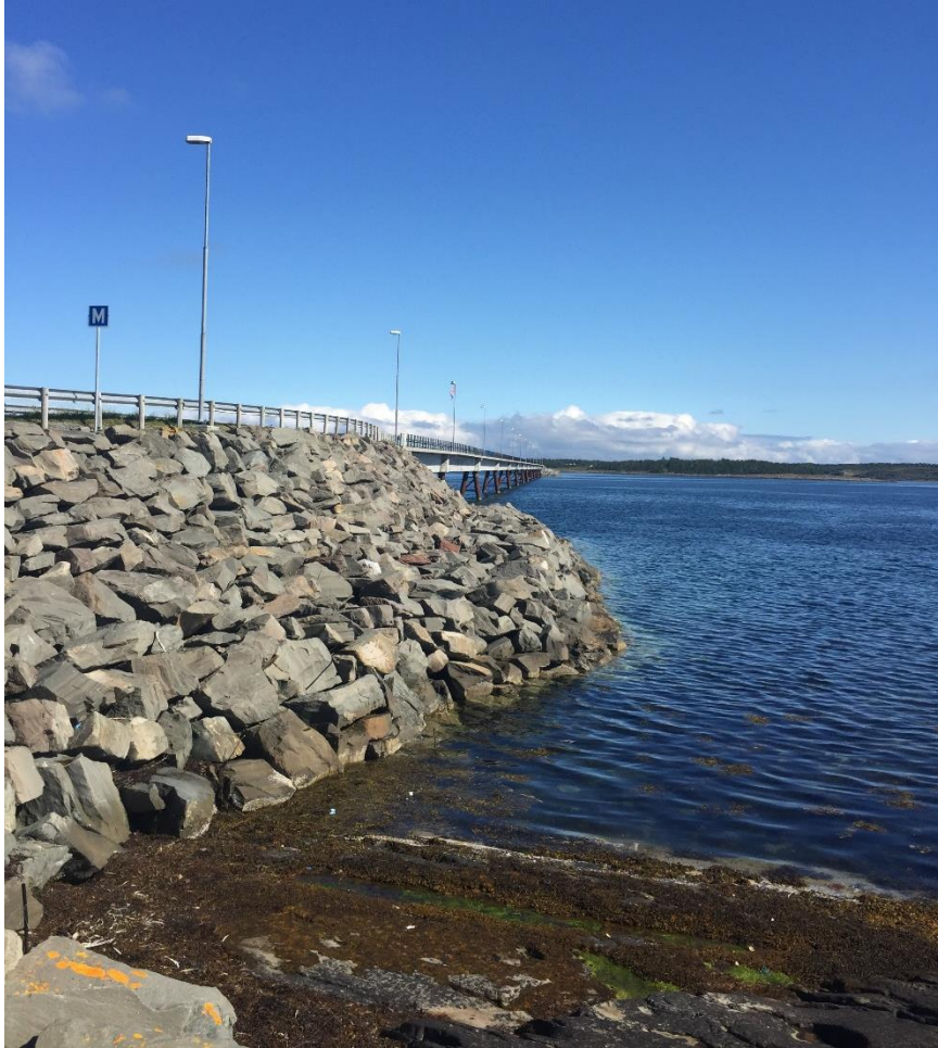
Bilde 9: Brua sett fra Kråkvåg
