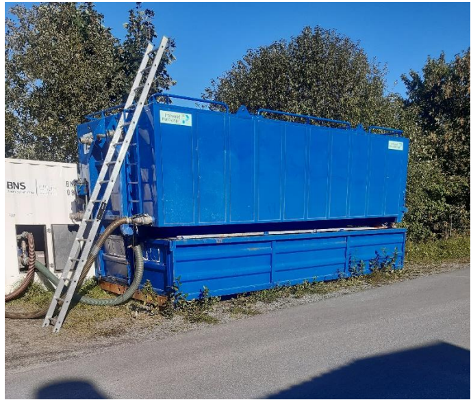
Figur 8: Polymerdosering skjer i avvanningsenhet (hvit container) plassert ved siden av avvanningscontainer. Bilder: Rambøll (venstre), Innherred Renovasjon (høyre).
