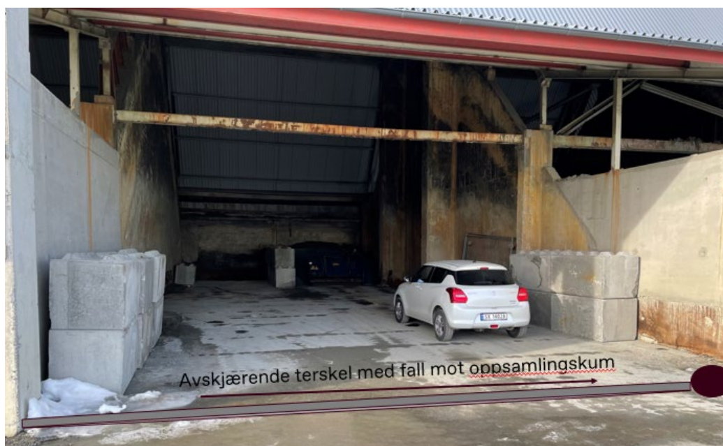
Figur 4: Bås med terskel og fall mot tett kum (etableres) hvor forurenset vann kan hentes med sugebil.
