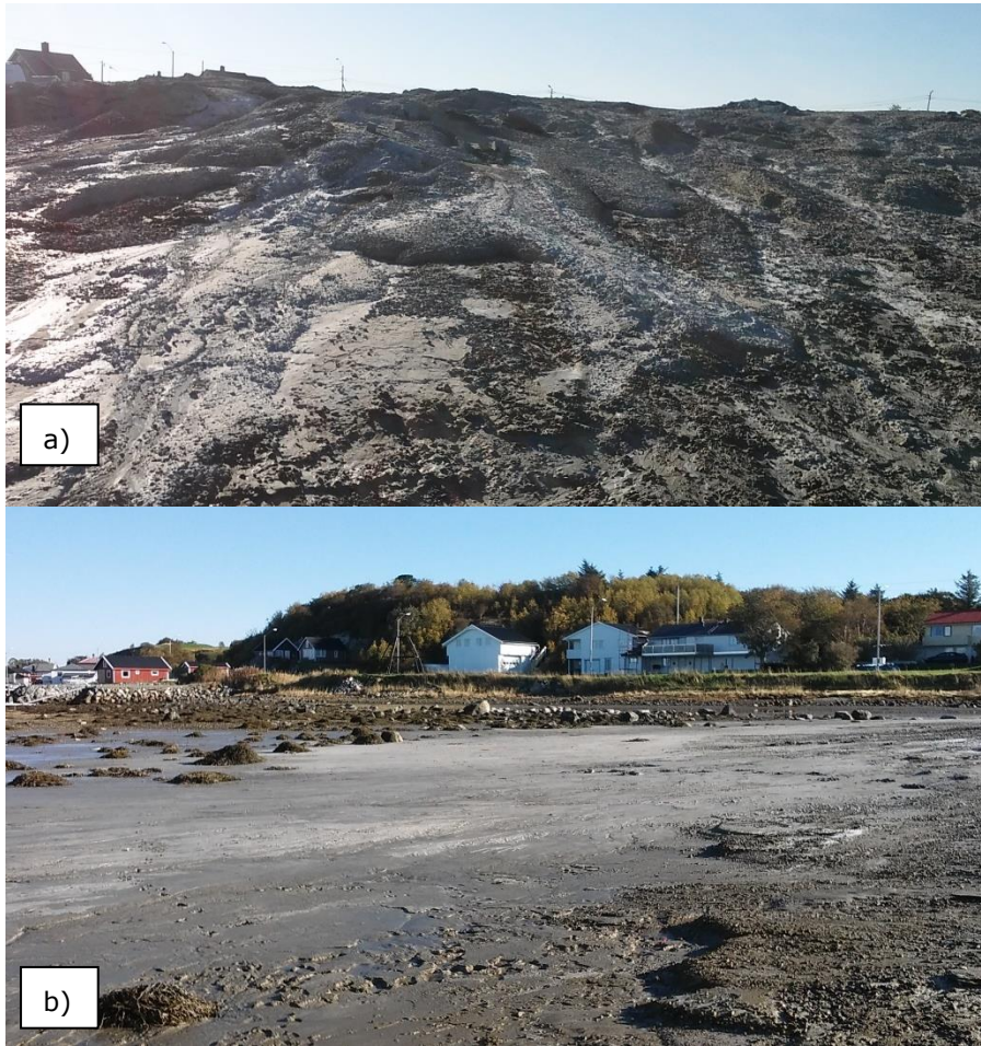
Figur 3. Fjæresone ved utslippssted fra AS Uthaug Sementstøperiet. a) Kompaktert sementslamdeponi på land. b) En del av deponerte slam og vaskevann har rennet ut i sjøen.
