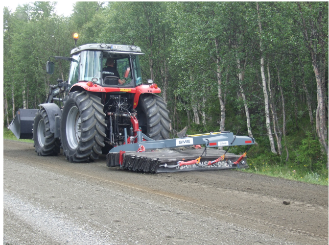
Bilde 5. Gummislådd med skrapjern til vedlikehold er mye brukt for å holde vegbanen intakt og fri for vegetasjon. Bilde: Statsforvalteren
