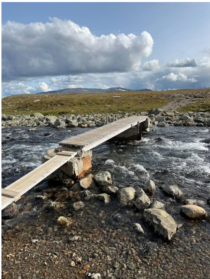
Figur 19: Brua over Bessa ved Bessvatnet (9). Skal renoverast i 2026
