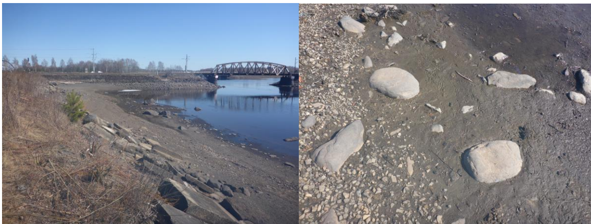
Figur 2-4: Illustrasjonsbilder av sørsiden på tiltaksområdet, med togbrua sørover vist i bildet t.v. med fyllmasser, stein og betong. Bunnen består her av stein og mudder (t.h.). Prøver fra sørsiden ble tatt ut med boreriggen i september 2022, og besto av mudder.
