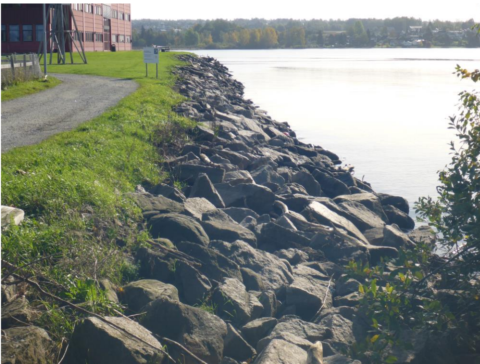
Figur 2-14: Illustrasjonsbilder av strandlinja langs tiltaksområdet for Espern Eiendom tatt 26. september 2023 ved høy vannstand i Mjøsa. Bildet illustrerer områder dominert av bløkkstein i øvre del av strandkanten med gradvis overgang mot finere substrat ved økende avstand fra land (Foto: Anja Fosshaugen/Sweco).
