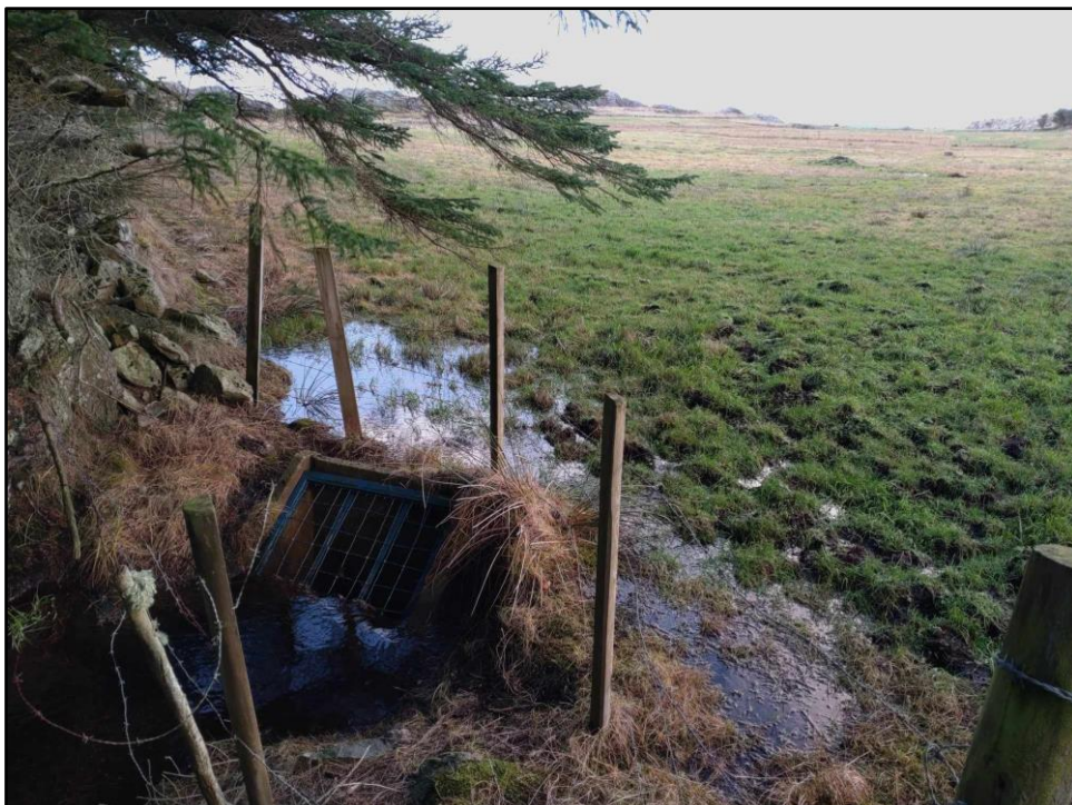
Figur 4. Bekken går inn i et inntak med rist før den renner 620 meter under bakken (punkt nr. 4 i figur 2).
