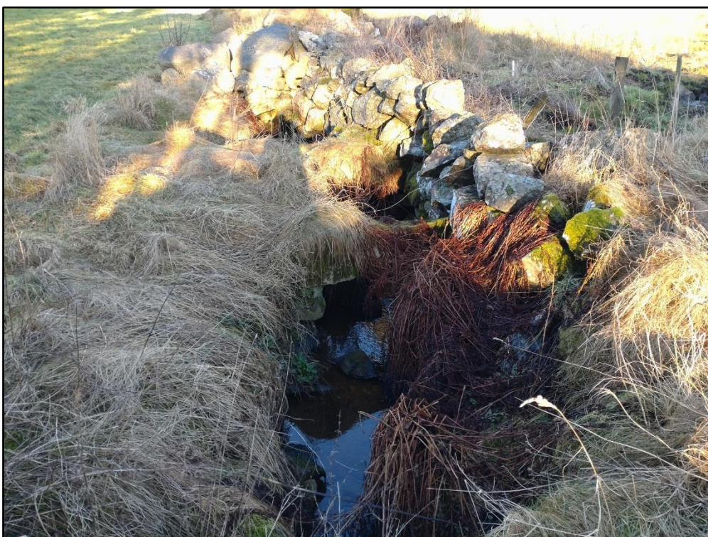
Figur 5. Knappt 50 meter oppstrøms strekningen man har definert som øvre grense (lavt potensial) for anadrom/katadrom strekning, renner vannet gjennom en forbygning, som antagelig er et vandringshinder på de fleste vannføringer.
