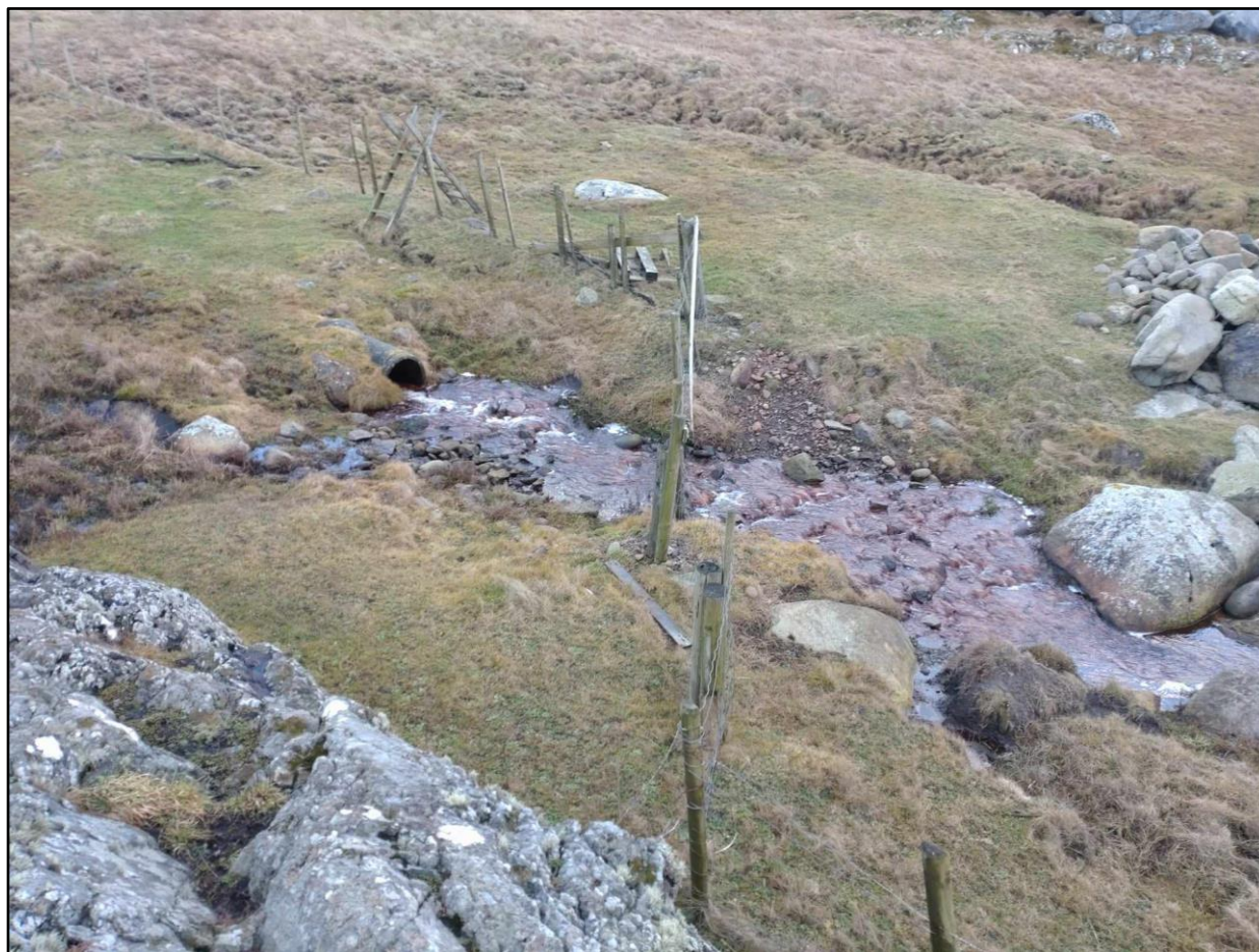
Figur 6. 50 meter fra sjøen kommer bekken ut av røret (punkt nr. 1 i figur 2)
