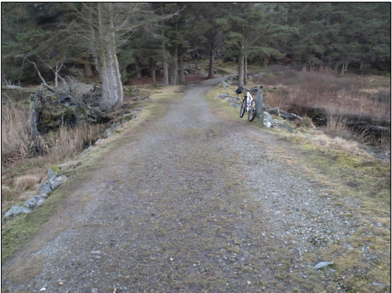
Figur 5. Vei og veifylling som krysser myra i den nordlige enden (punkt nr. 4 i figur 2). Denne kan kun forseres av ål.
