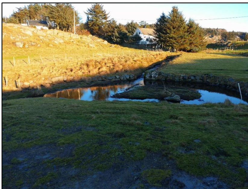
Figur 9. 30 meter oppstrøms parkeringsplassen, ble det på starten av 2010-tallet etablert flere rensedammer for å samle opp næringsavrenning fra jordbruket. Dammen ble delvis utgravd for finmasser i 2024, for å gi bedre skjul- og leveområder for fisk (punkt nr. 7 i figur 2).
