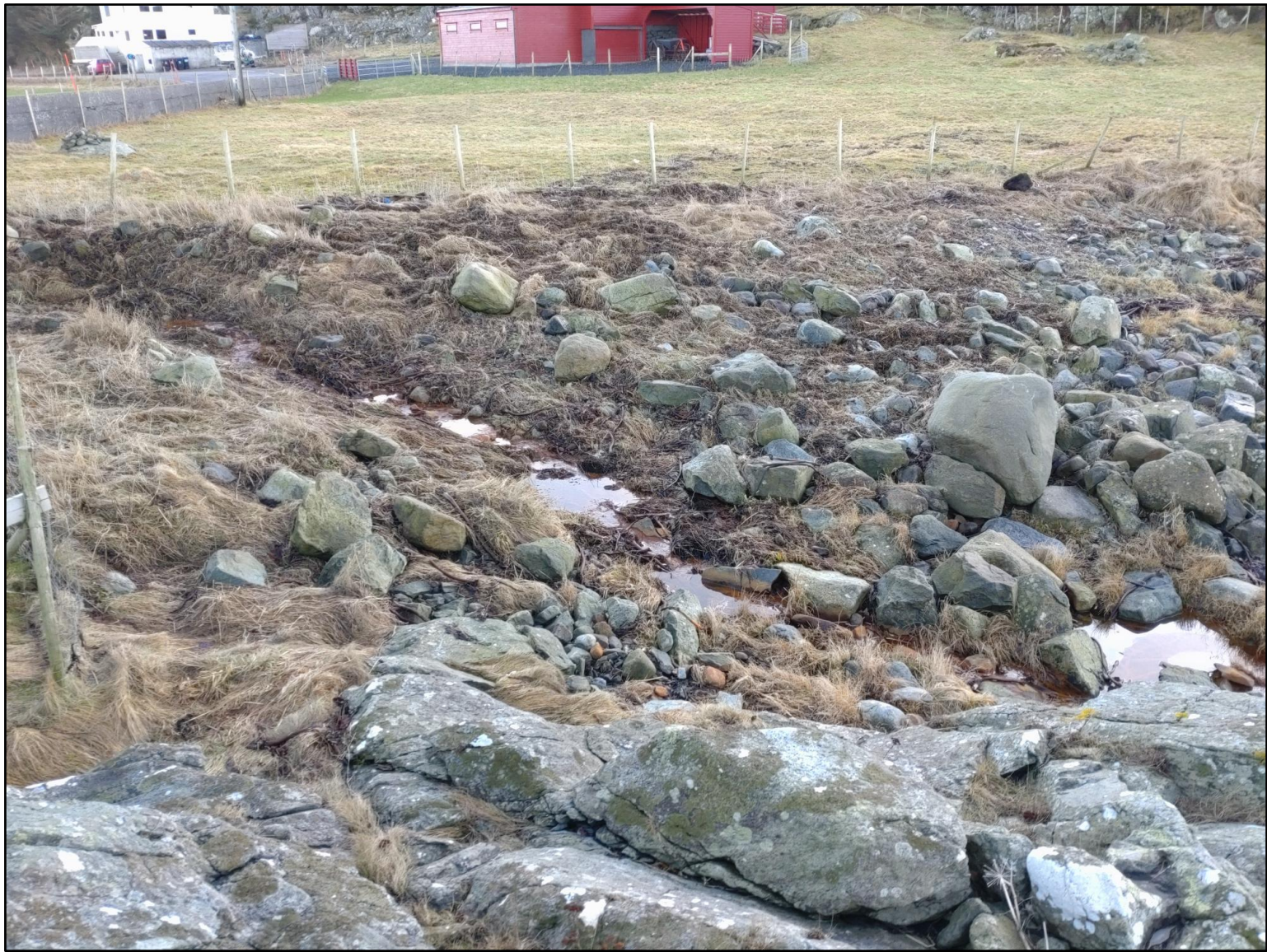
Figur 3. Bekken er lagt i rør under fulldyrka areal og fylkesvei 4844, før den går åpent til sjø de siste 20 meterne (punkt nr. 1 i figur 2).
