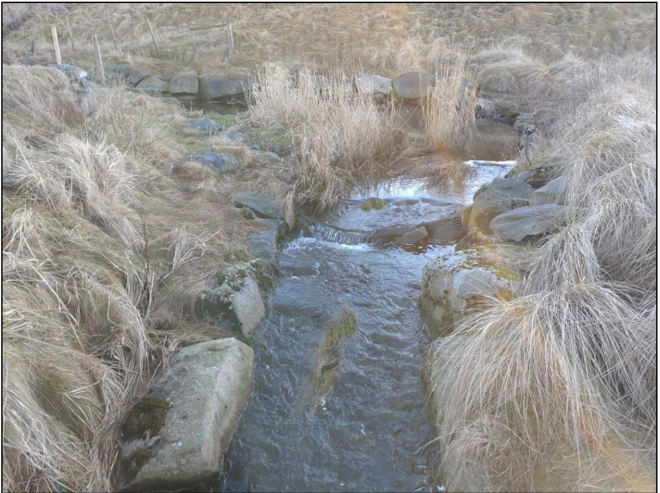
Figur 5. Store deler av Sandvebekken er sterkt erosjonssikret, og nedre del er ikke noe unntak (punkt nr. 3 i figur 2).
