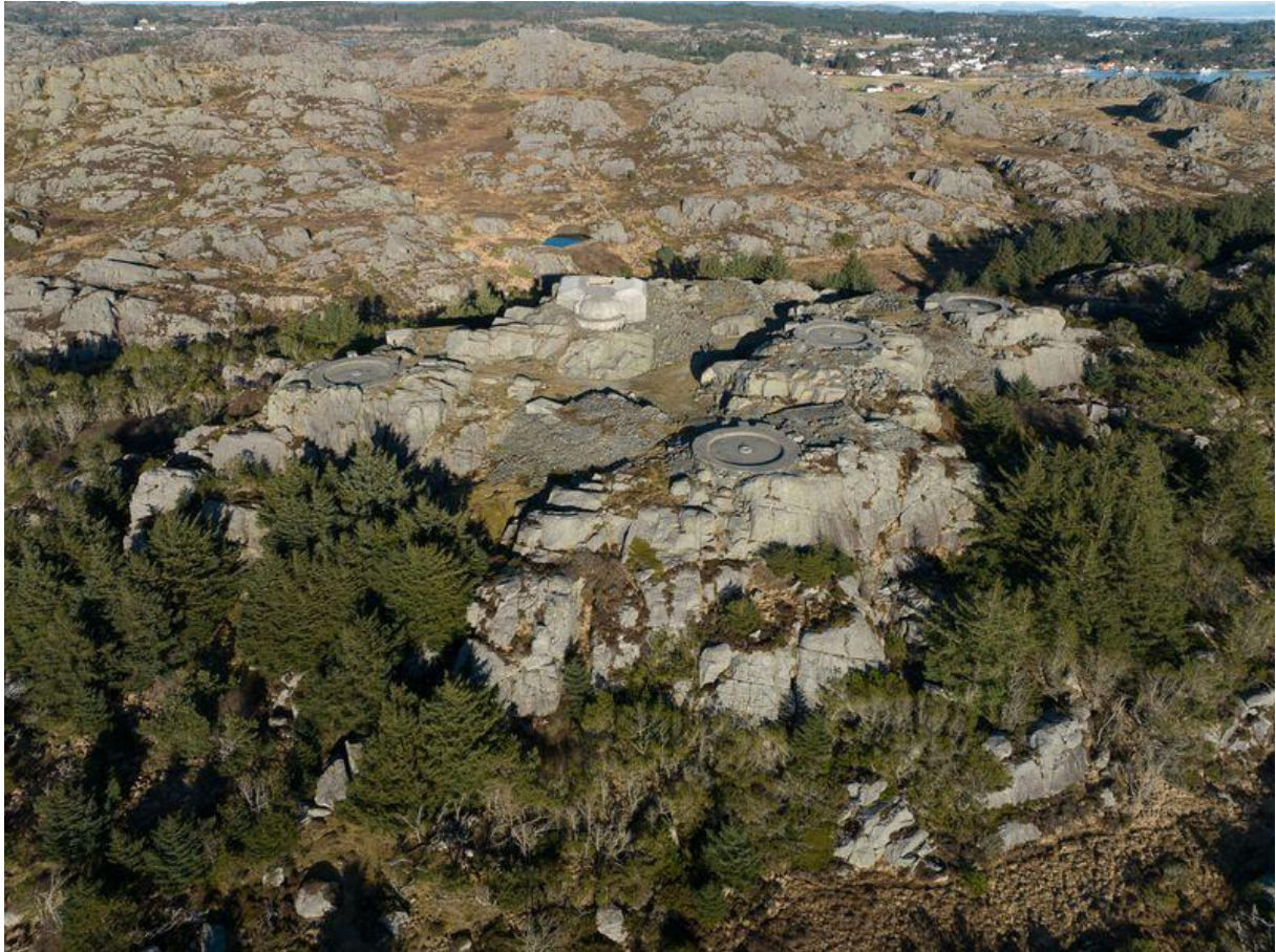
Fig. 5.2.13. Syreneset fort slik det blei bygga under andre verdskrig, foto Oskar K. Bjørnstad.
