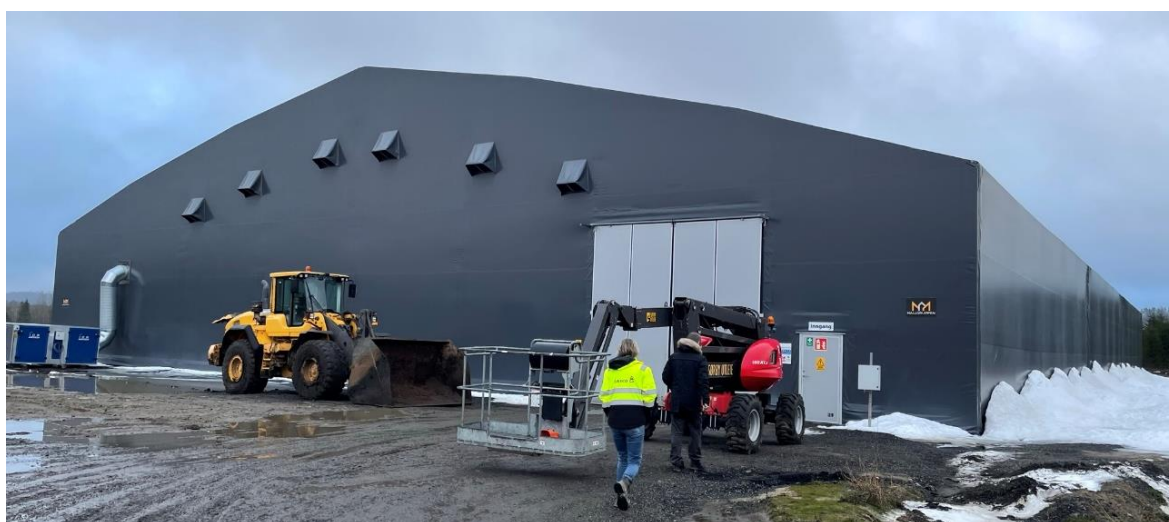
Figur 5. Plasthallens sørvestlige fasade sett fra porten inn til området.
