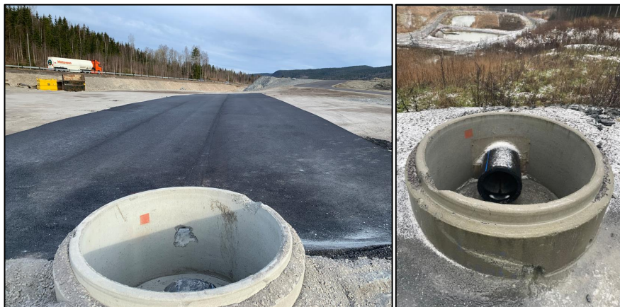
Figur 1: Viser det asfalterte området for behandling av betong sett mot nord (venstre bildet) og syd (høyre bildet)..
