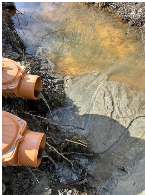
Figur 3: Rørene som slipper smeltevann ut i resipient. Vannprøvene tas direkte fra utslippet.
