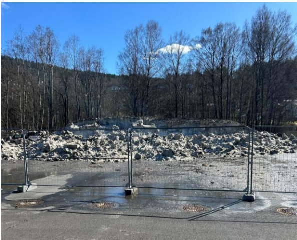
Figur 2: Overvannskummer som smeltevann fra snødeponiet drenerer til.
