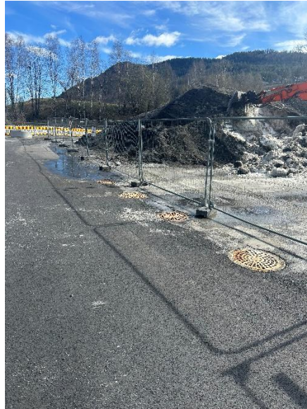
Figur 2: Overvannskummer som smeltevann fra snødeponiet drenerer til.
