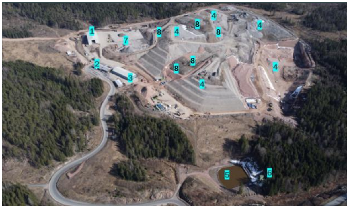
Figur 1: Oversiktsbilde av anlegget på Lindum Oredalen AS: 1. Karantenehall, 2. ADM-bygg, 3. Lagerhall, 4. Deponiområde, 5. Rensdam, 6. Renseanlegg, 7. Askesortering, 8. PFAS-celler og renseanlegg.
