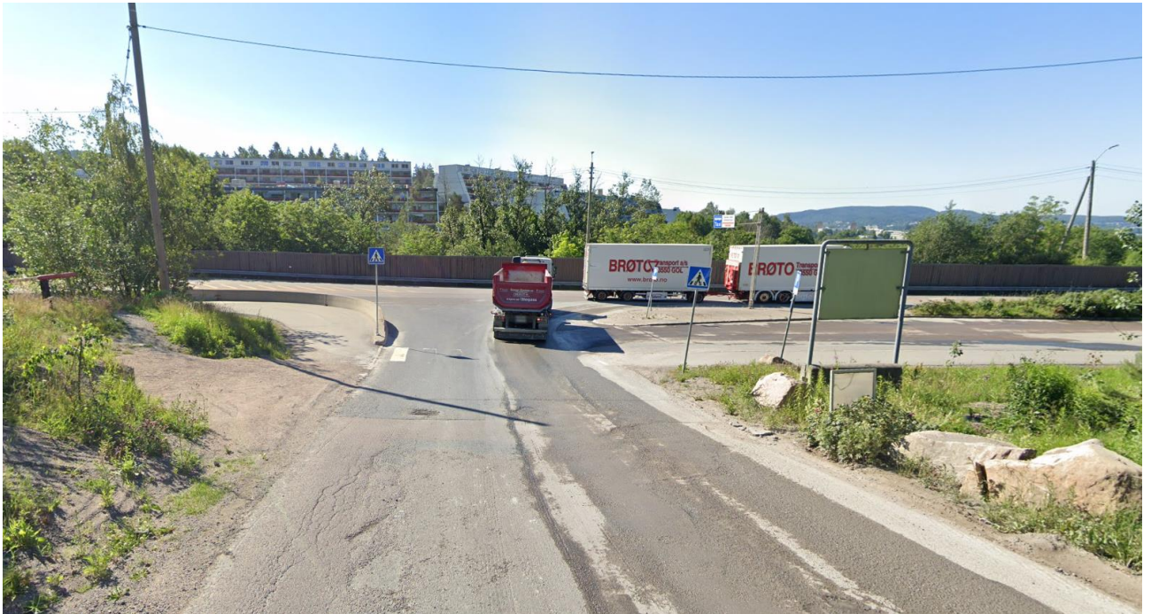
Figur 5: Adkomstveien sett inn mot krysset med rv. 4. Kilde: Google street view, juni 2024
