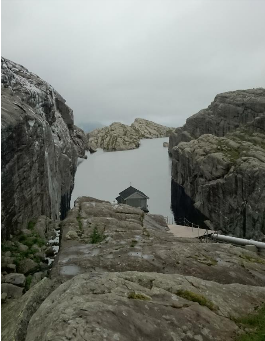
Bilete 7. Utsikt over Ramsskredvatnet med pumpestasjon. Foto: Joachim Bråthen Schedel.
