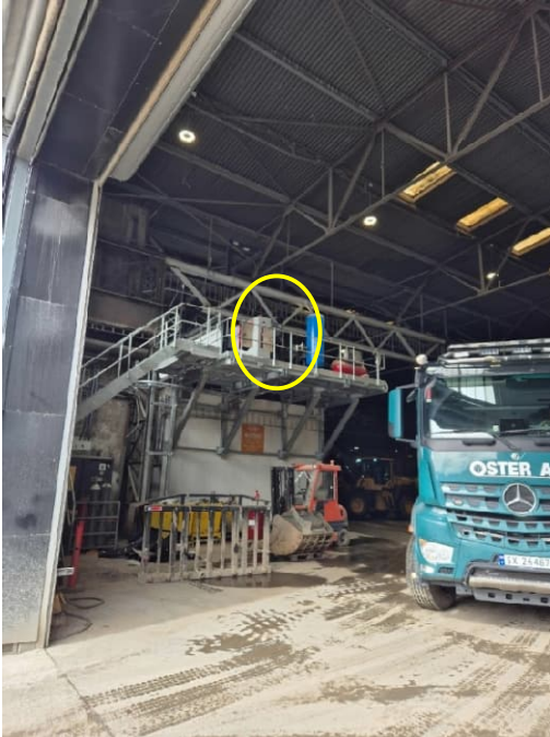
Figur 3: Posisjon måler inne i driftshall, sett fra portåpning til port 2.
