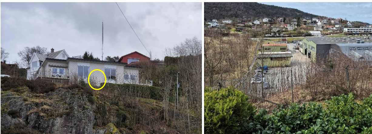
Figur 4: Venstre: Støymåler på fasade til Furukollen 27B, sett fra parkeringsplass til Envir. Høyre: sikt til portene i sørfasaden til Envir, sett fra målepunkt på Furukollen 27B.
