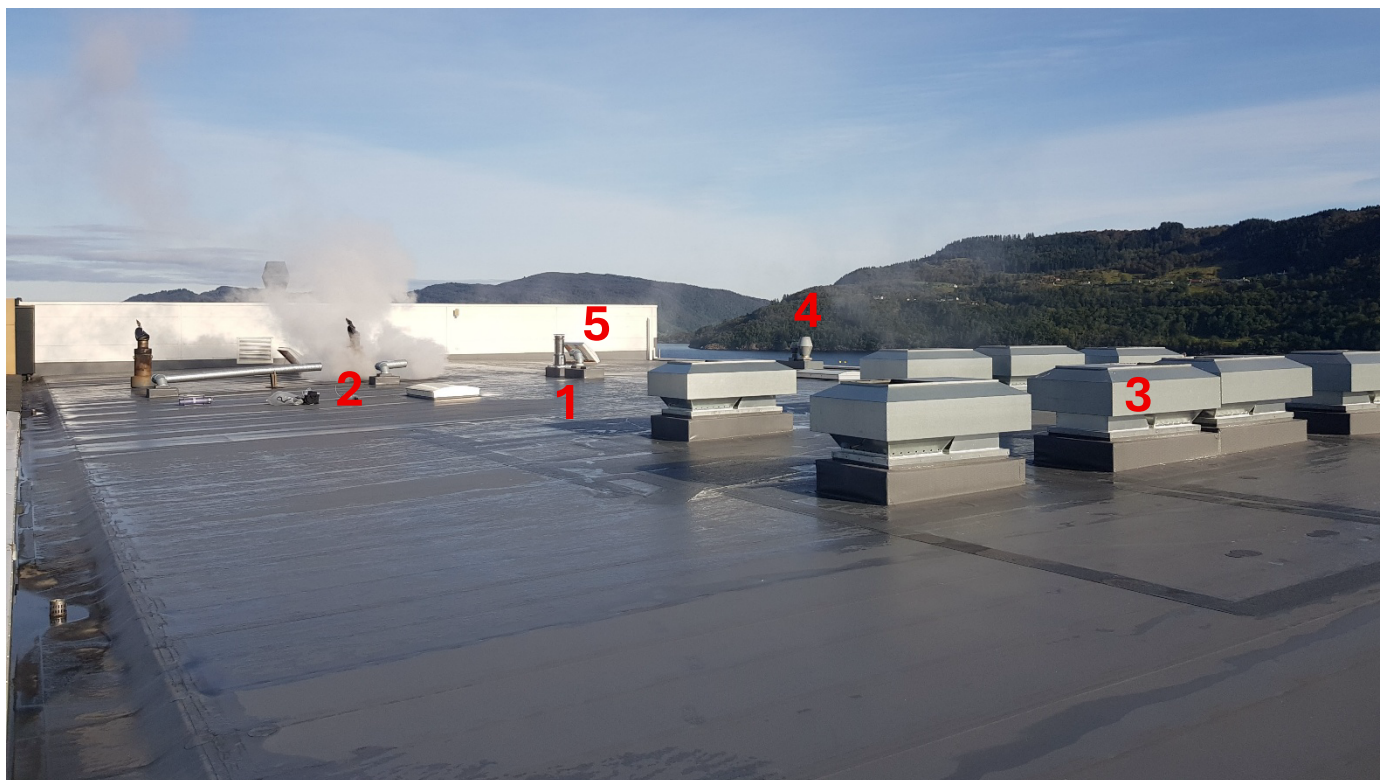
Figur 4. Oversiktsbilde prøvepunkter tak. 1: småtøyrulle, 2: hoved- og kombirulle, 3: tørketromler, 4: tørketunnel, 5: takluke.
