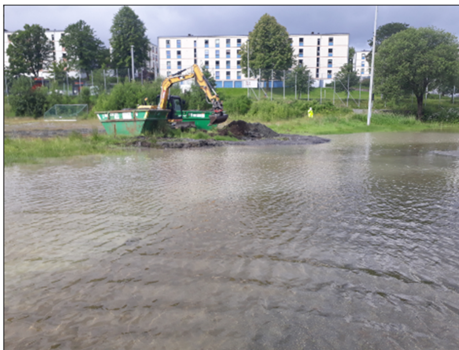
Figur 2-4: Foto viser vann på overflaten som står i kontakt med grunnvannet slik at deponimassene er vannmettet. Bildet er tatt mot vest sommeren 2019. Foto: Gry B. Stenersen
