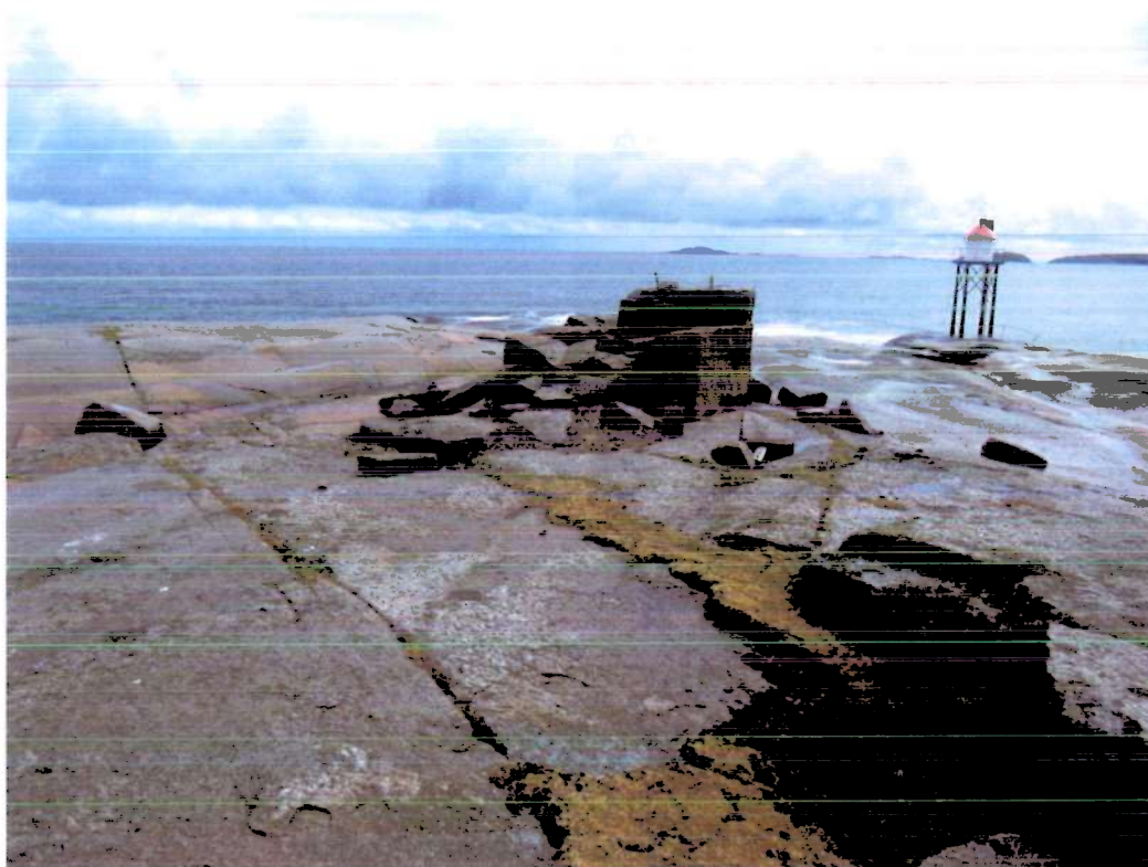
Leistein, ID 5. Fundament for tidligere fyrtårn. Foto: Jan Brendalsmo.
