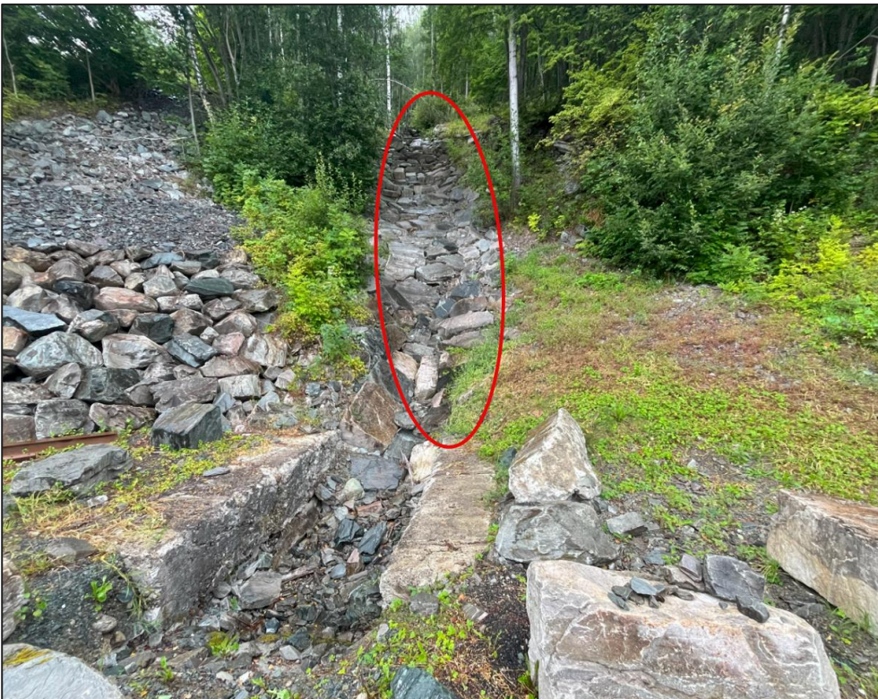
Figur 5. Steinsetting i nedre del av bekkeløpet mot adkomstvegen.
