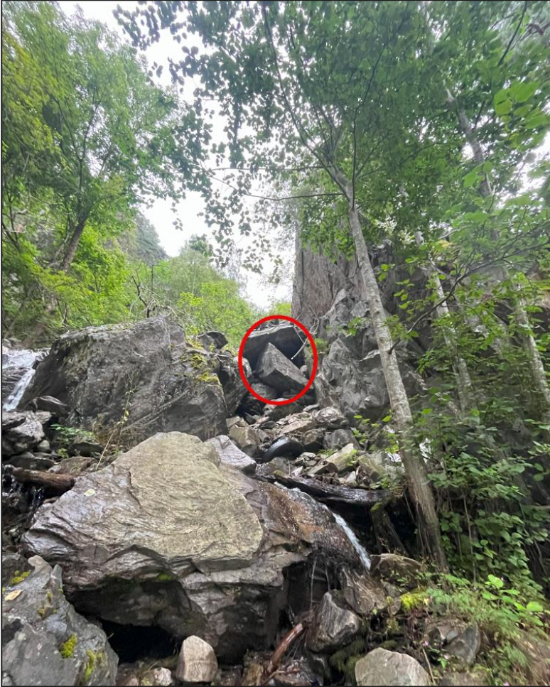
Figur 4. Det tette østre bekkeløpet sett fra nedsiden.
