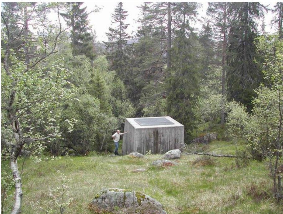
Figur 1 Foto av tilsvarende luftehus for Haukerei kraftverk i Fyresdal
